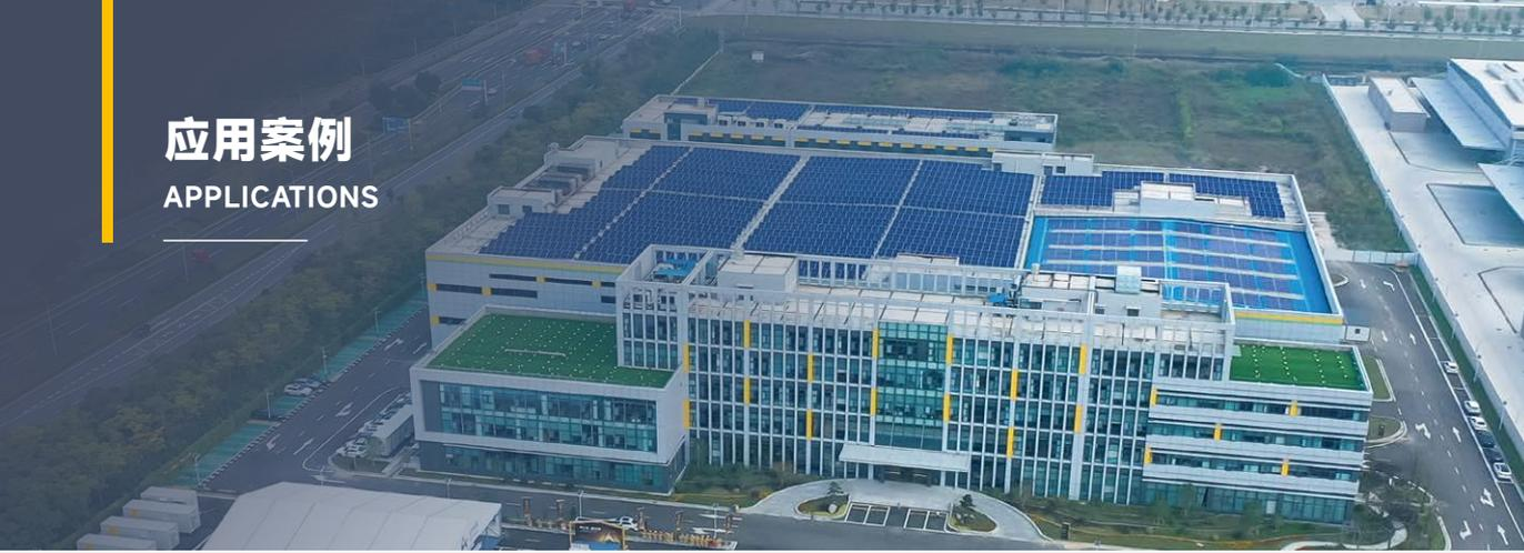
以沃太能源全球总部通州园区为试点，建成了集双碳管理、能耗监测、光伏、储能、充电桩、楼宇自控、安防、消防、数字孪生等14个模块于一体的国内领先的低碳智慧园区云平台，于2023年10月投运，对园区内1.2MW分布式光伏、2.5MW/7.5MWh储能、478kW充电桩、1MW空调、30kW光储一体机以及各类设备进行运维监测与管理。
