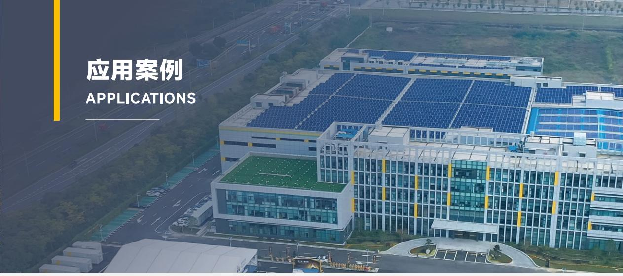
以沃太能源全球总部通州园区为试点,建成了集双碳管理、能耗监测、光伏、储能、充电桩、楼宇自控、安防、消防、数字孪生等 14 个模块于一体的国内领先的低碳智慧园区云平台,于 2023 年 10 月投运,对园区内 1.2MW 分布式光伏、2.5MW/7.5MWh 储能、478kW 充电桩、1MW 空调、30kW 光储一体机以及各类设备进行运维监测与管理。
